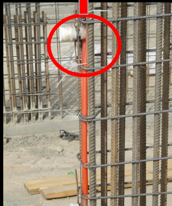
عبور لوله های تاسیساتی ضمن آرماتور بندی
