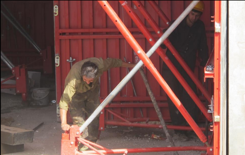
جانمایی قالب مطابق نقشه
