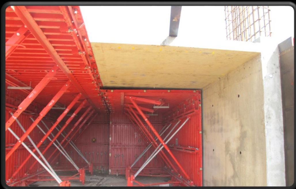
پایان گیرش بتن و باز کردن قالب
