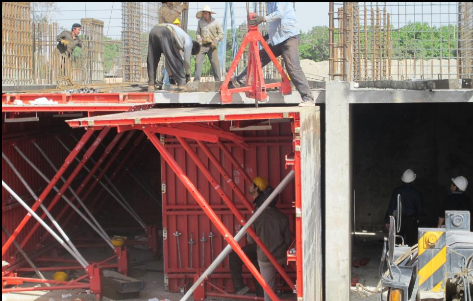
بردن قالب به طبقه بعدی
