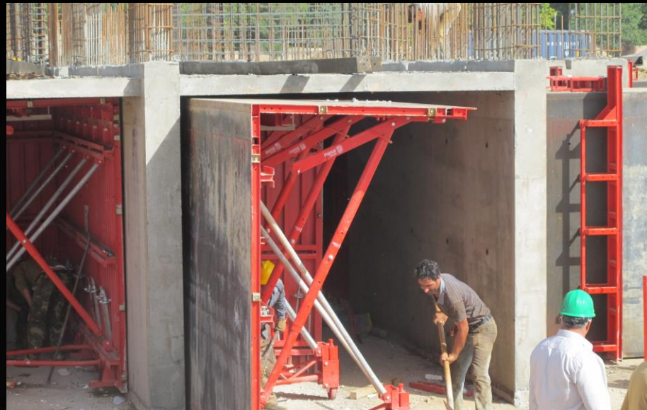
باز کردن قالب و خارج کردن آن
