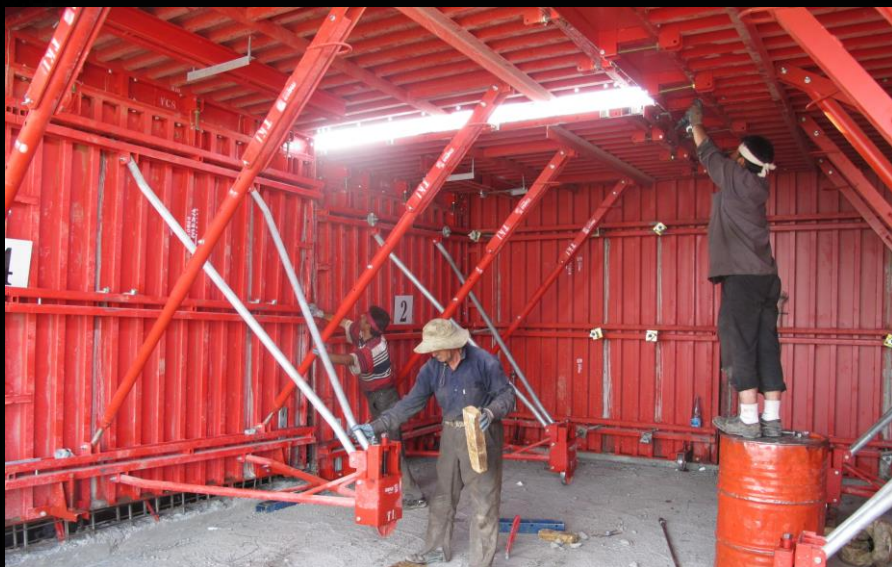
جا گذاری آخرین قسمت قالب
