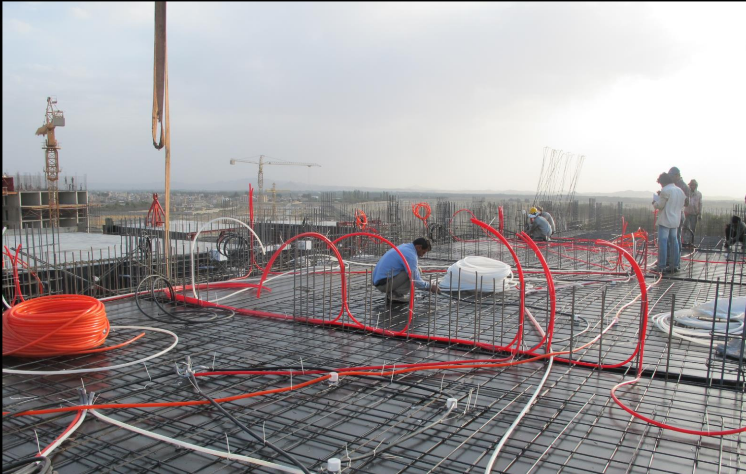
عبور کلیه لوله های تاسیساتی قبل از بتن ریزی
