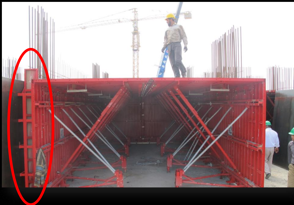
جا گذاری قالب های لبه دیوار
