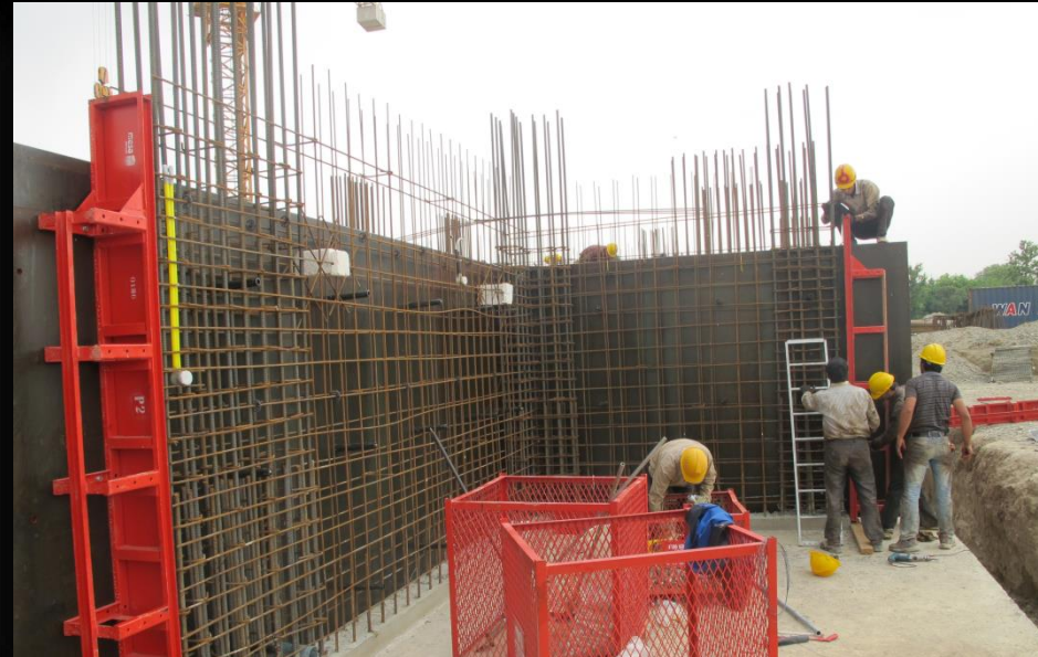
تکمیل بدنه بعد از آرماتور بندی
