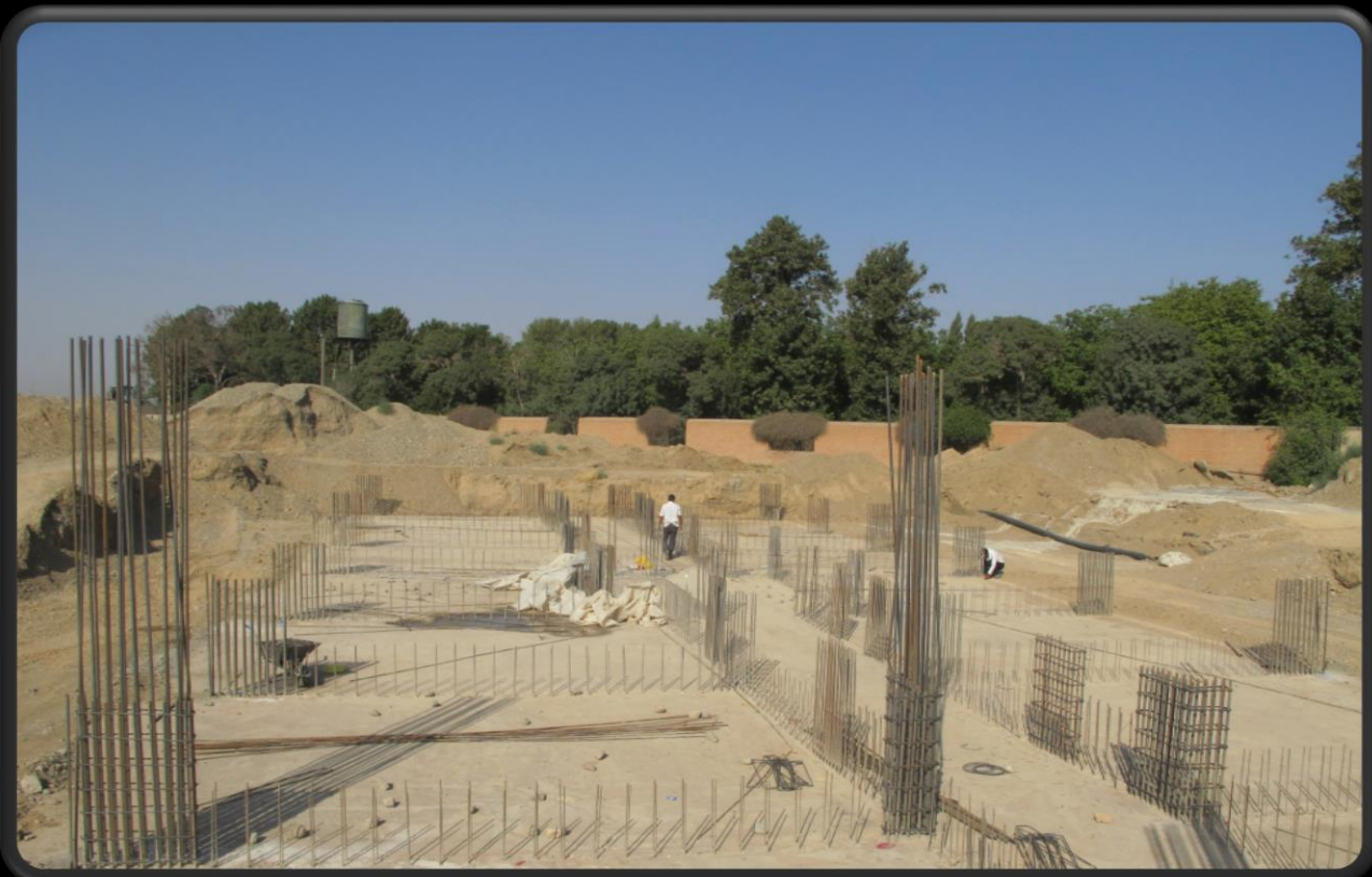
اجرای فونداسیون گسترده
