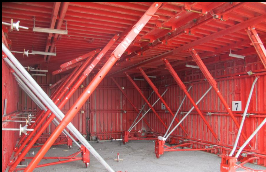
پایان جاگذاری قالب ها و تنظیم آن
